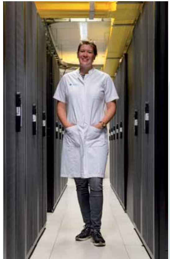
Melissa Niemantsverdriet in het datacentrum van het Catharina Ziekenhuis.
